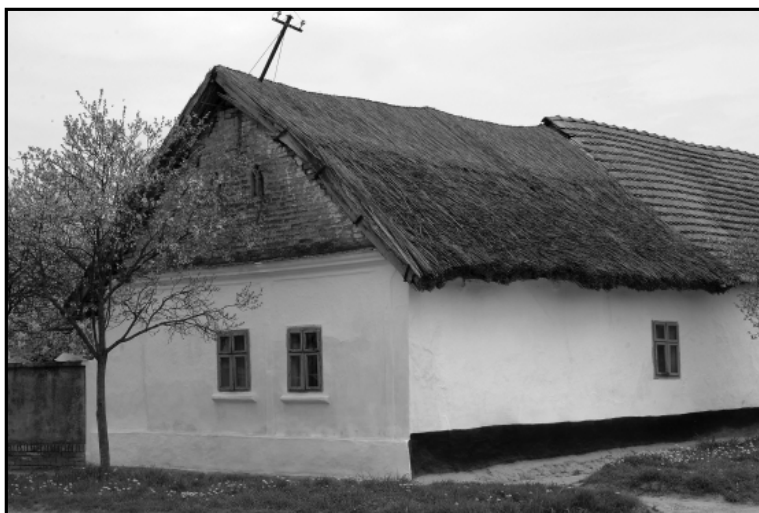
Slika 4. Jedna od posljednjih preostalih kuća nabijača u Sonti, pod trščanim krovom, do danas je, ipak, ostala sačuvana tek na nekolicini fotografija. Foto: V. Stojanović.
